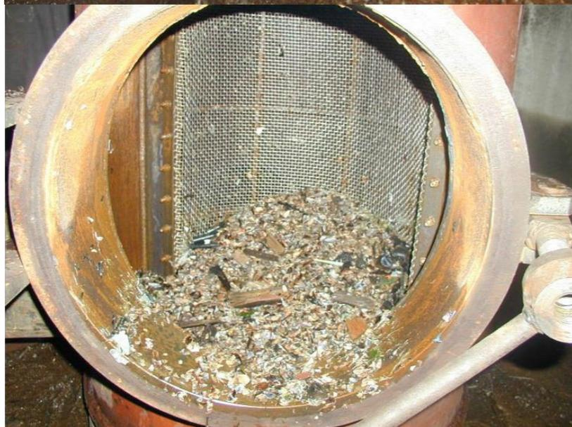
Отложения на внутренней поверхности трубок конденсатора, а также загрязнение трубных досок и трубок со стороны входа воды более крупными предметами приводят к:
