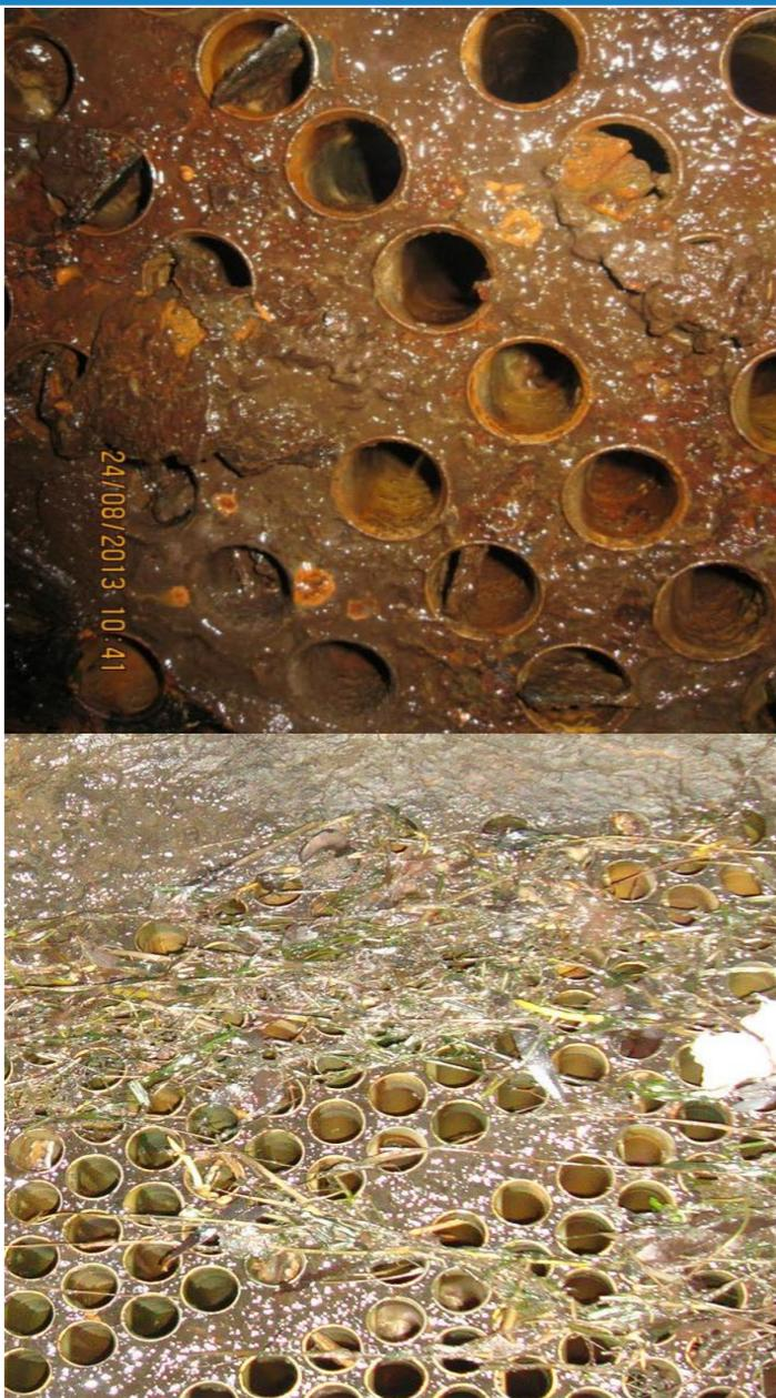
Очистка конденсаторов паровых турбин ТЭС и АЭС является весьма актуальной задачей, от решения которой зависит улучшение теплопередачи в трубных пучках и повышение эффективности выработки электроэнергии.
